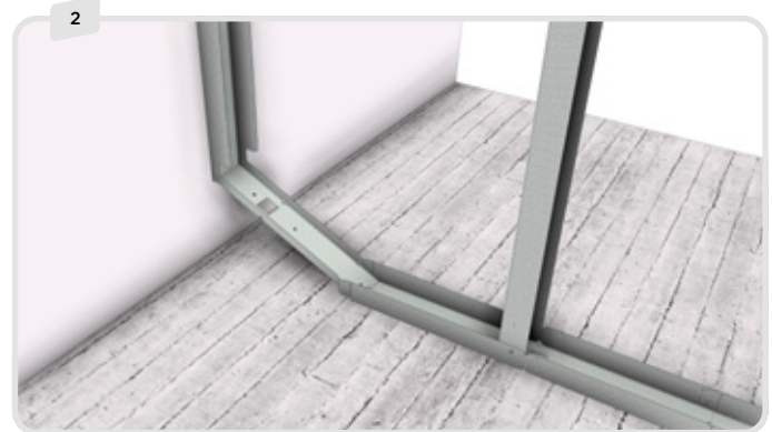
Stecken Sie das C-Modul in das I-Modul. Insérez le module C dans le module I. Inserire il modulo a C nel modulo a I.
