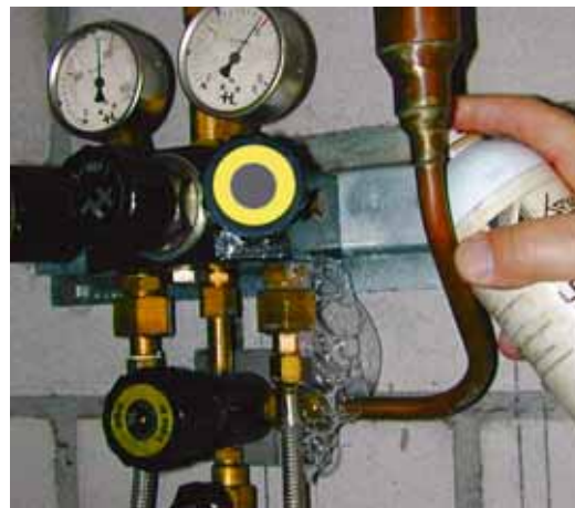
Bild 26: Prüfung der Anlage auf Dichtheit
