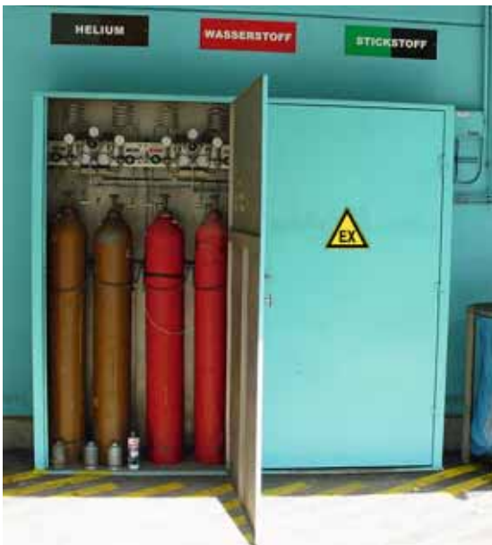
Bild 4: Zentrale Gasversorgung
