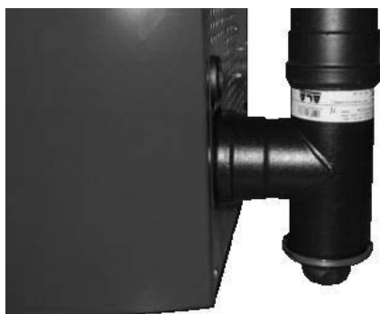
Fig. 55 - Reinigung des Rauchgaskanals
