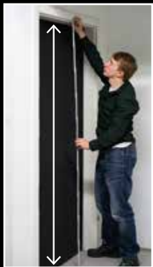
Vom Fussboden bis zum oberen Zargenfalz messen.
